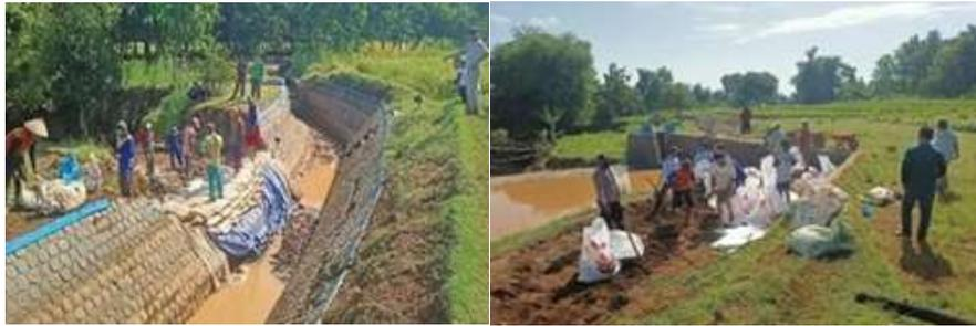
**Gambar 4. Perbaikan lining saluran**
